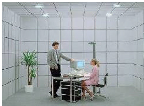
Figure 6.1 : Exemple d'installation performante d'éclairage d'un bureau (bas niveau d'éclairement de la pièce et appoint par lampe de bureau) [12]
