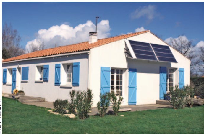
Captteurs solaires thermiques installés en toiture d'une maison individuelle.
