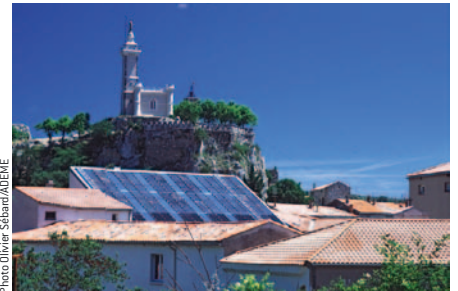
Maison de retraite équipée de panneaux solaires couvrant un pan entier de l'une de ses toitures.
