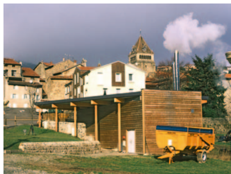
Vue d'ensemble de la commune de Saint-Sauveur en Rue. La chaufferie alimente le réseau de chaleur qui parcourt 870 m pour chauffer 9 249 m 2 de bâtiments communaux.
