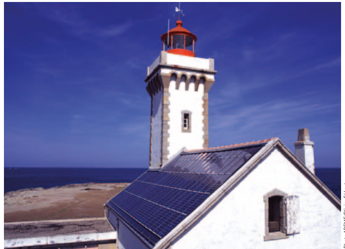
Le phare de l'île des Cygnes dans l'archipel des Glénans fait face à la mer. Le versant méridional de sa toiture est équipé de capteurs solaires photovoltaïques bien intégrés dans l'architecture du bâtiment.
